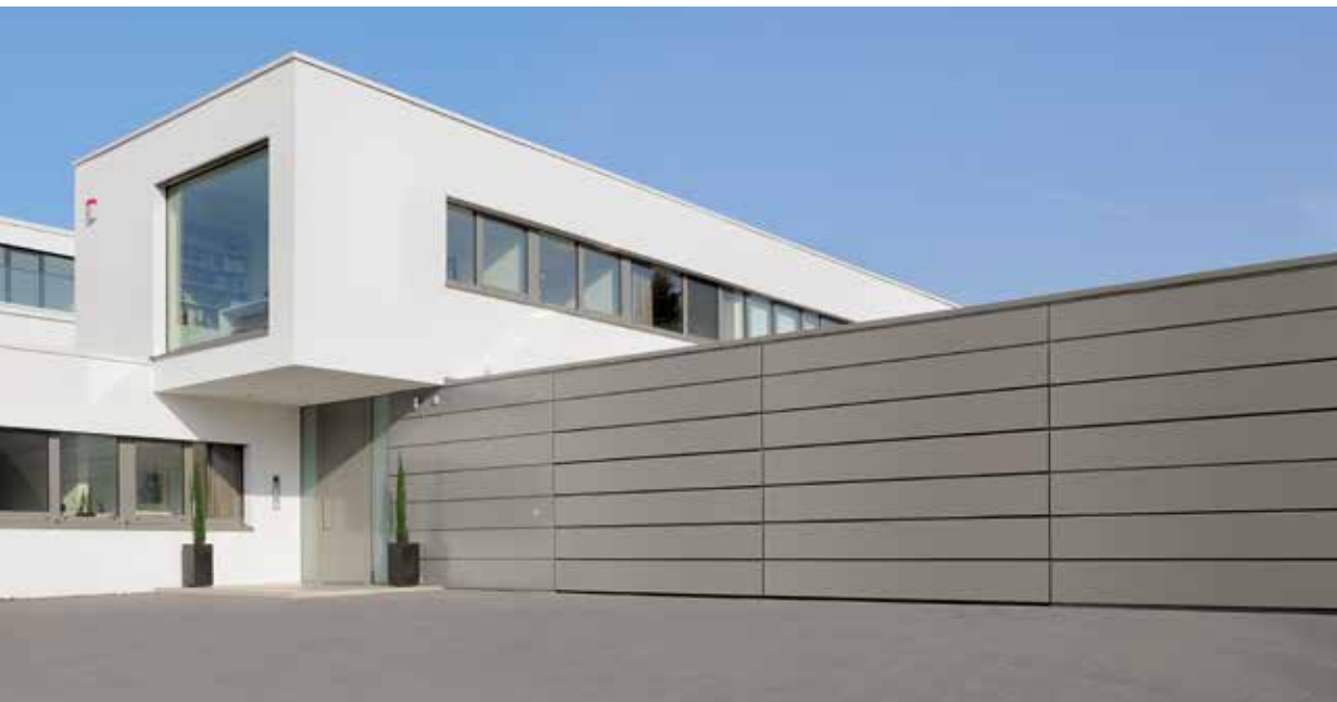
Opláštění hliníkovými sendvičovými deskami u zákazníka
